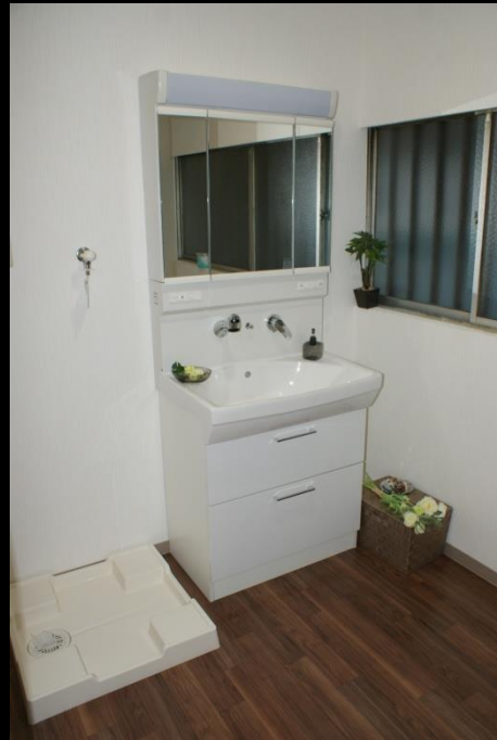
洗面台・洗濯機パン 新設
