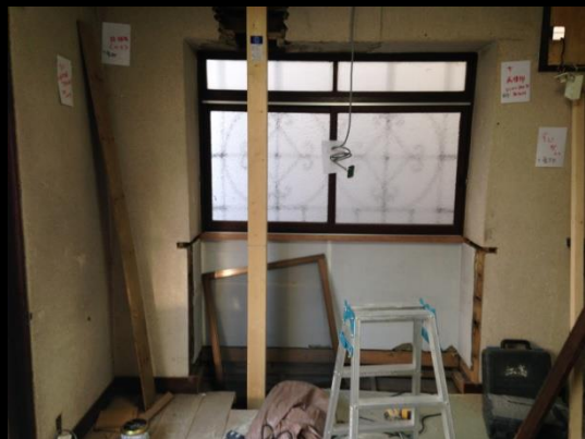
構造補強工事の様子
